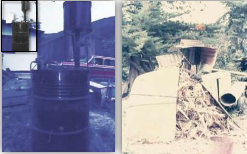
FIGURA 25b. Biodigestores anaeróbicos contruidos con recipiente de aceite, experiencia desarrollada por el autor de la presente memoria descriptiva conjuntamente con Don Luis Zambrano en su casa-taller-molino en la Aldea de Mesa de Adrian. Bailadores, Estado Mérida 1982.
