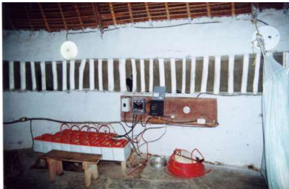
FIGURA N° 42. Recuperación del banco de baterías, controlador e inversor planta fotovoltaica INPARQUES
