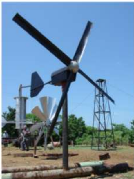
FIGURA 5b. Aerogenerador en proceso de construcción
