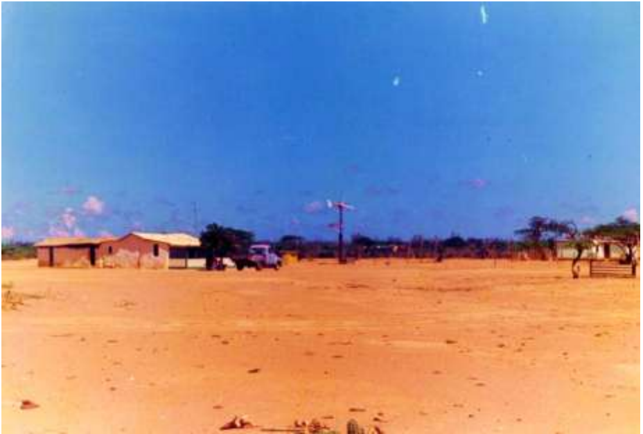
FIGURA 31. Viviendas Interconectadas al Servicio Eléctrico Planta de Generación Híbrida Eólico – Solar Fotovoltaica
