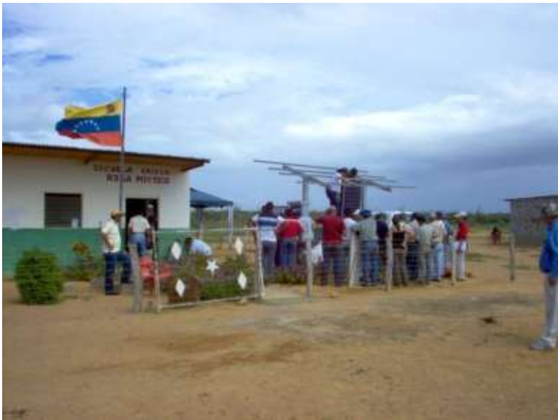
FIGURAS 43 a, b y c. Instalación de la planta de generación de electricidad fotovoltaica Escuela Básica Comunidad de Jacuque, Municipio Falcón, Estado Falcón.
