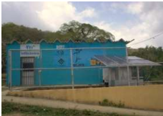
FIGURA 46. Planta de generación fotovoltaica instalada en la Comunidad de Jacura. Programa Piloto de Electrificación de INFOCENTROS del Ministerio de Ciencia y Tecnología- Fundación INFOCENTROS – FUNDACITE Falcón.
