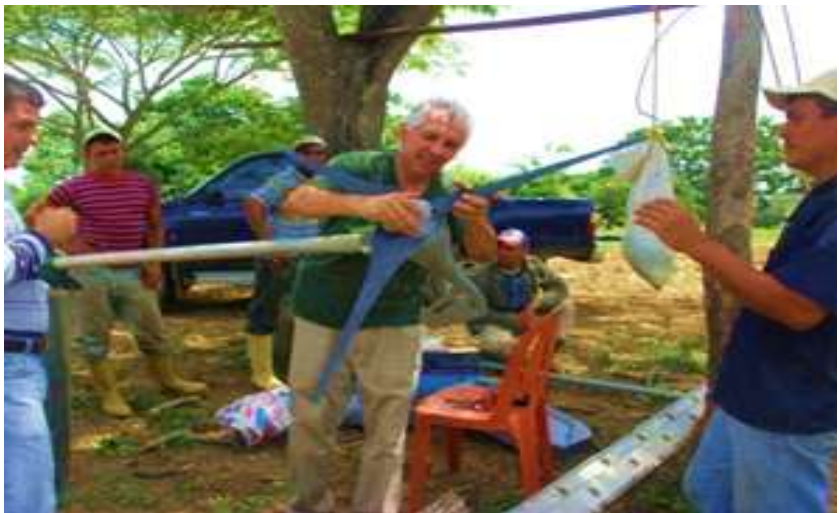
FIGURAS 51. Instalación del aerogenerador de la planta híbrida fotovoltaica-eólica.
