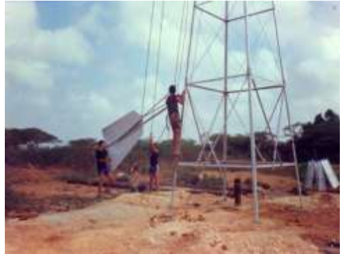
FIGURA 28. Labores de instalación de Aerobomba Multipala en la Pitahaya
