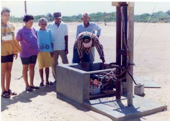
FIGURA 8. Banco de baterías del generador híbrido “eólico solar fotovoltaico”
