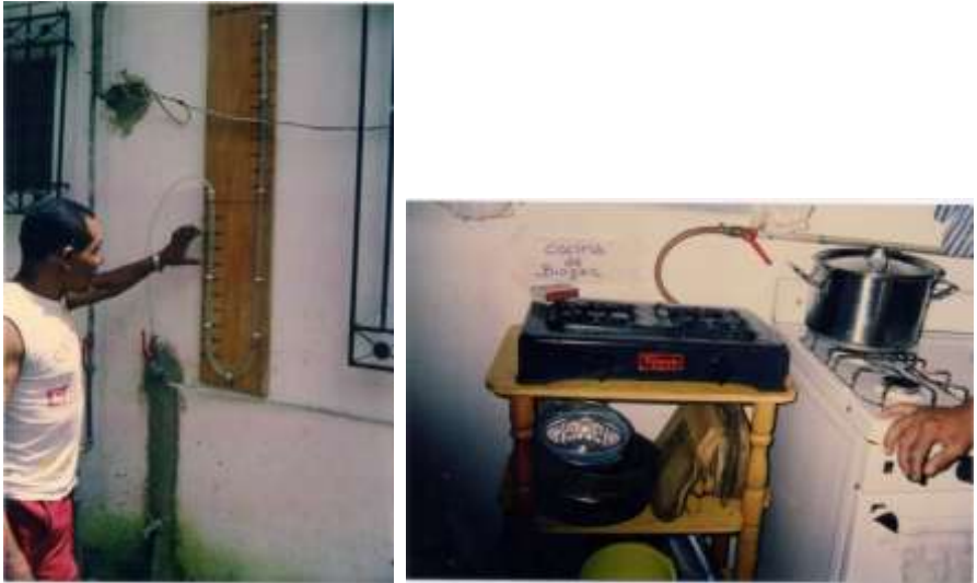
FIGURA 26. Medidor de presión de biogás producido por el biodigestor y cocina doméstica funcionando con el gas metano producido en la digestión anaeróbica en una vivienda rural de la sierra de Falcón
