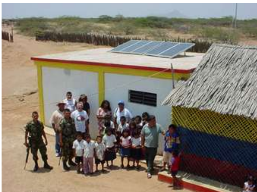
FIGURA 36 a y b. Instalaciones del Wapulee del Kasusain operando con energía eléctrica generada por la planta fotovoltaica.
