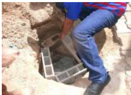
FIGURAS 53 a, b y c. Excavación del pozo, colocación de bloque de estabilización.
